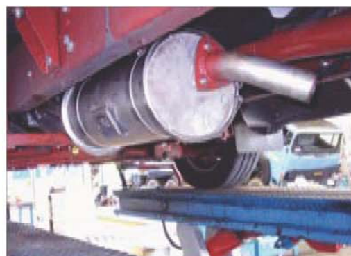
Einbau der Partikelfilter
